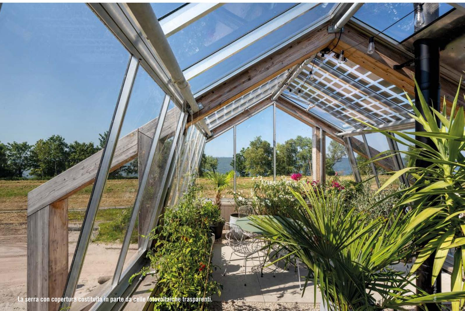
La serra con copertura costituita in parte da celle fotovoltaiche trasparenti.
